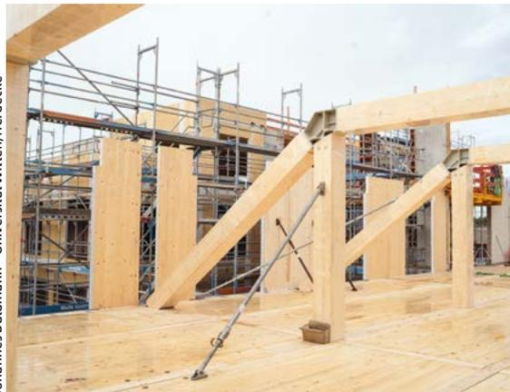
Die Stahlzugbänder der Sprengwerke wurden in den Geschossdecken „versteckt“.
