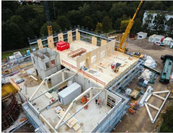
Montage der Wand- und Deckenscheiben. Links im Bild der Veranstaltungsraum im EG mit den Holz-Stahl-Sprengwerken.
