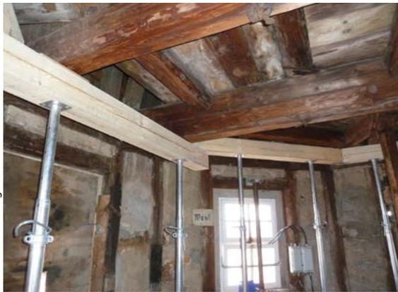
Abb. 7: Ausgeführte Abstützkonstruktion
