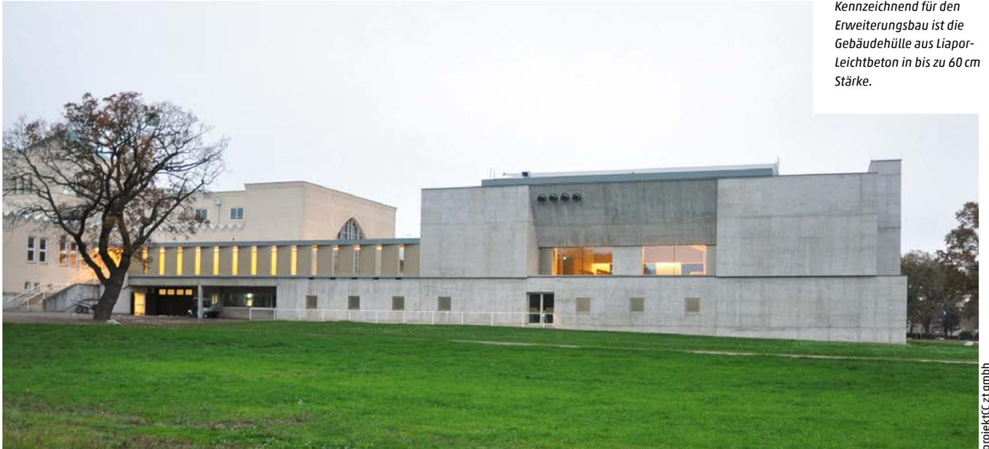
*Kennzeichnend für den Erweiterungsbau ist die Gebäudehülle aus Liapor-Leichtbeton in bis zu 60 cm Stärke.*
