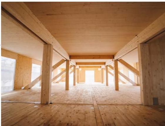
Das 1. OG im Holz-Rohbau. Gut zu erkennen: die Stoßdeckbretter, die die Brettsperrholz-Elemente zu Deckenscheiben verbinden.
