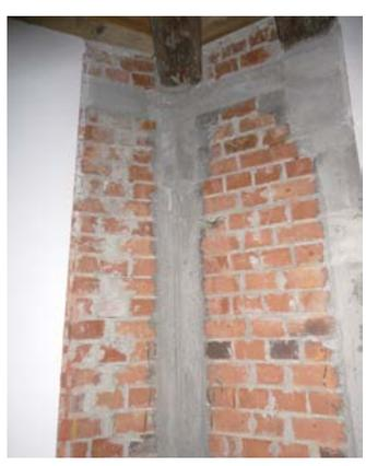
Abb. 13: Sichtfenster als Beleg für die neue Stahlbetonkonstruktion
