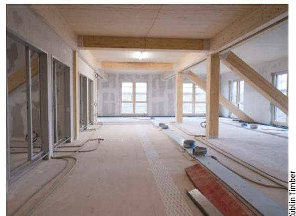
Die Sprengwerksdiagonalen im 1. OG bleiben schmückendes Element. Zum Teil werden sie in Trennwände integriert.
